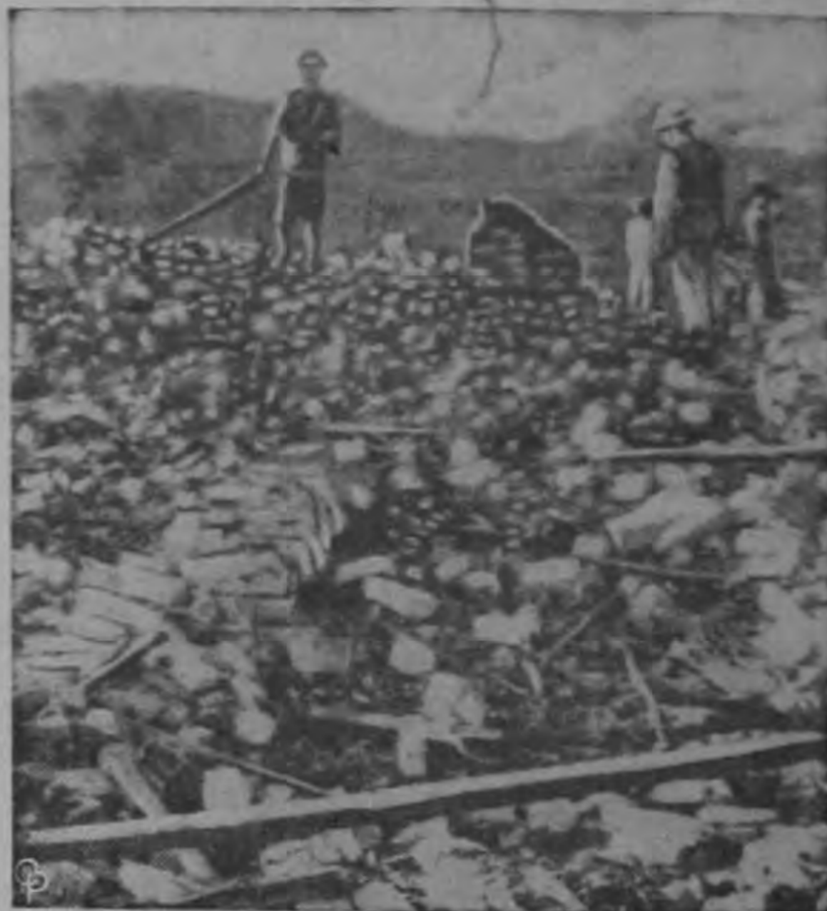
Trabajadores de salvamento buscan posibles víctimas entre las ruinas de una fábrica de pólvora en Río de Janeiro, Brasil, donde la explosión de 22 toneladas de dinamita produjo la muerte de 15 personas e hirió a más de 200. La explosión que estremeció a la población de Caxias, a 6 kilómetros de distancia, se cree que fué causada por un rayo. (INP)
